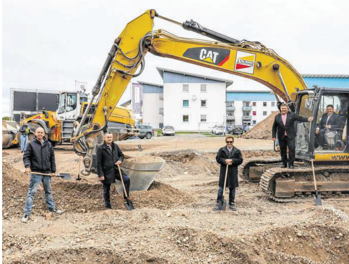
Baubeginn mit schwerem Gerät: Dass es mit dem Bauabschnitt eins an der Apfeltranger Straße nun los geht, freute Bauherr Roland Görgens, Oberbürgermeister Stefan Bosse, Bauherr Helmut Kilger, Vertriebsbeauftragter Dirk Bolsinger und Architekt Cornils Bartels (von rechts).
