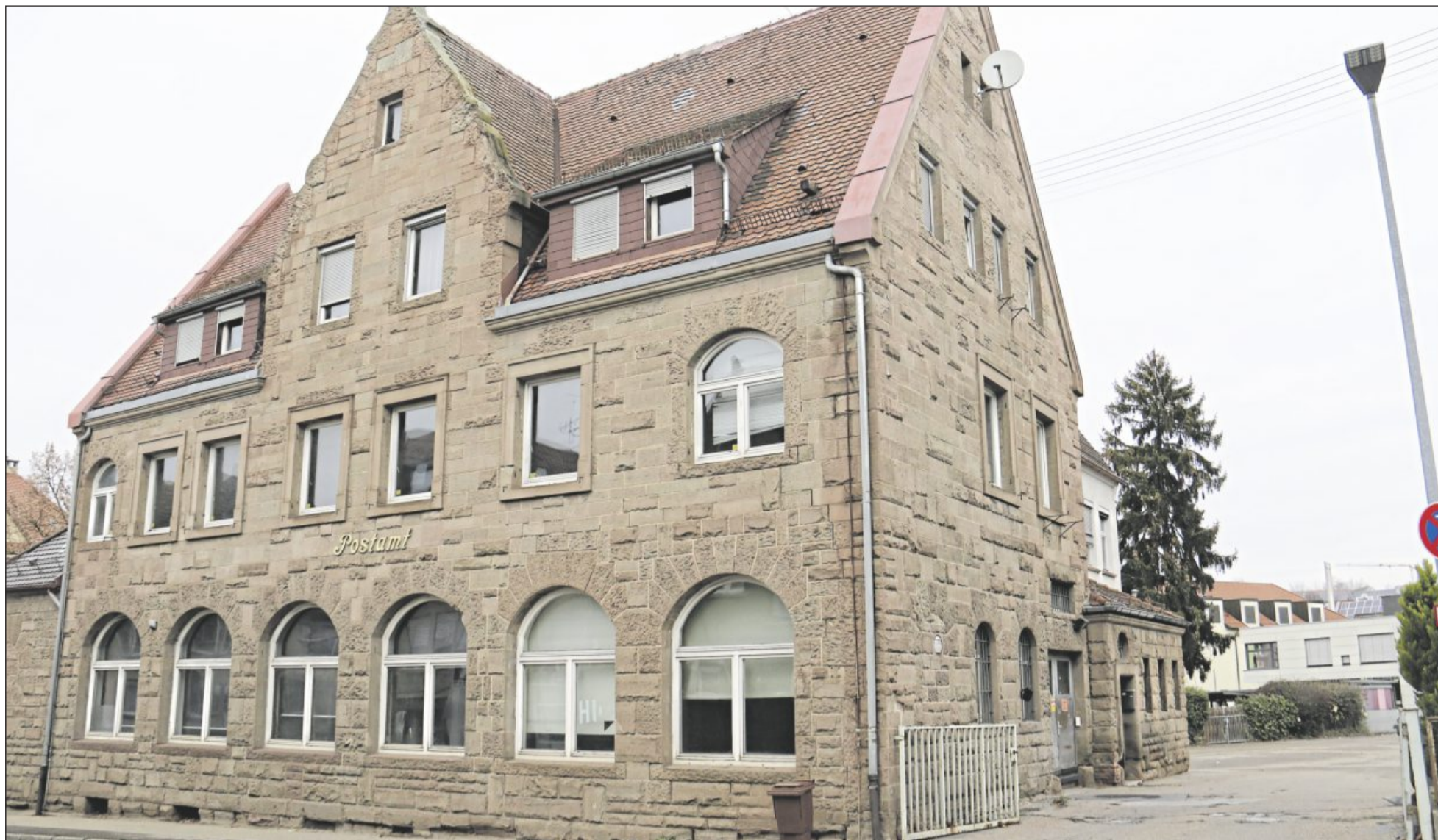
Das Erscheinungsbild des alten Postamts soll bewahrt, das Gebäude saniert und auf den modernsten Stand gebracht werden.
