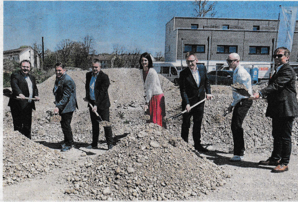
Freude über Spatenstich zum letzten Bauabschnitt: Stefan Bosse, Roland Görgens, Dirk Bolsinger, Caroline Moser, Helge Carl, Corni Bartels (Architekt) und Helmut Kilger.
